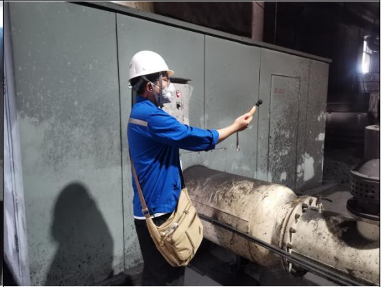
现场检测照片
